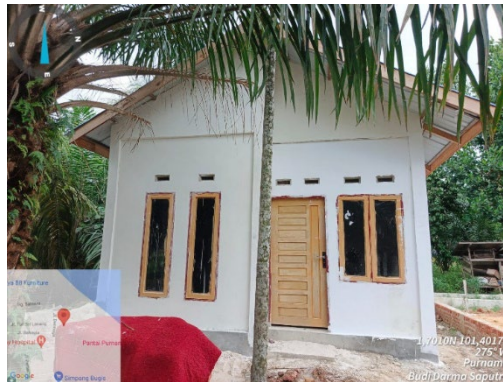
Gambar 3.3 Bantuan Rumah Layak Huni di Kel. Purnama, Kec. Duma Barat Sumber: Dokumentasi Dinas Perkim, 2024
