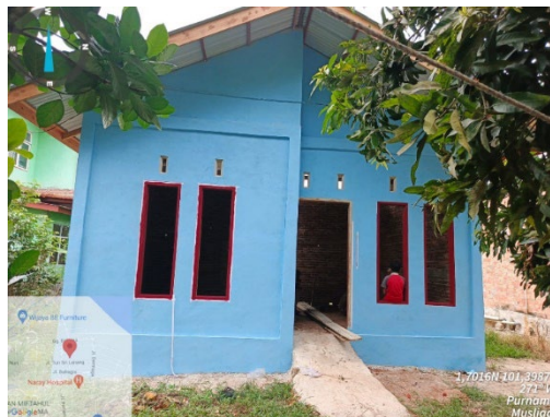
Gambar 3.4 Bantuan Rumah Layak Huni di Kel. Purnama, Kec. Duma Barat Sumber: Dokumentasi Dinas Perkim, 2024
